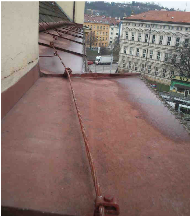
- nástřešní žlab a oplechování římsy s hromosvodnou soustavou
